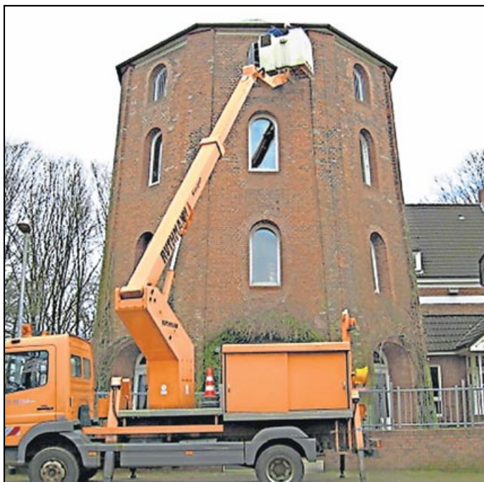
Arbeit mit großem Gerät: der Brutkasten für Mauersegler wurde mit Hilfe eines Hubsteigers unterm Dach des Turmes angebracht.
